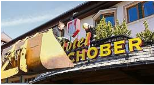
Bis 4. Juni sollen die Arbeiten fertig sein KK/HOCHSCHOBER
