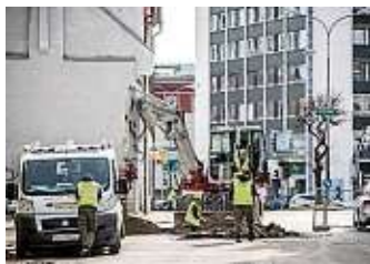
Nach Gasleck werden Rohre und Anschlüsse in der Villacher Straße erneuert
